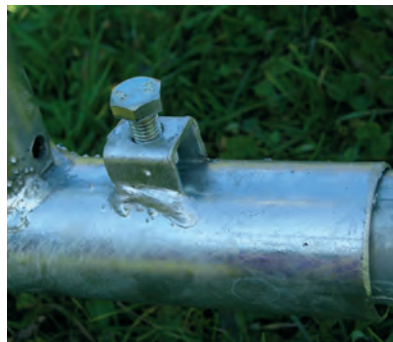
Klemmschraube, zum Fixieren des Einschubes an der gewünschten Länge
