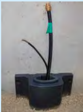
innenverlegter Abflussschlauch mit Abflussöffnung
