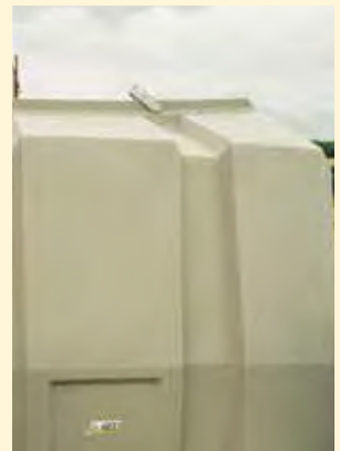
Zahlreiche seitliche Kantungen zur Verstärkung
