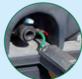
Tränkeanschluss mittels Montage-Set und Niederdruckventil
